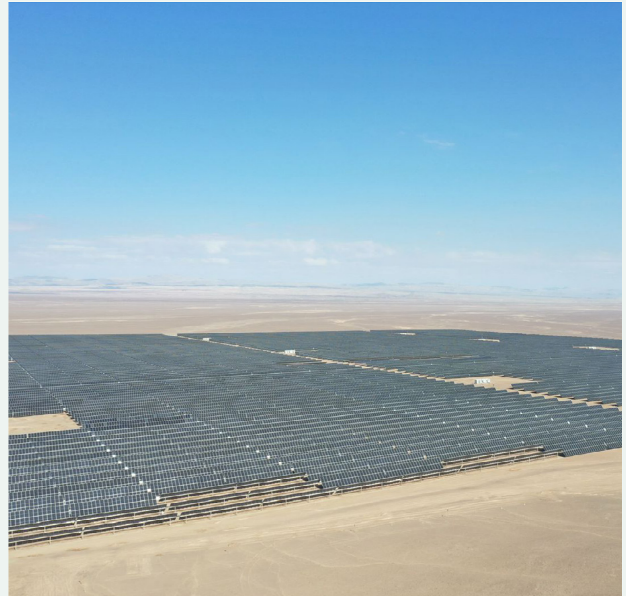
Planta fotovoltaica Coya, de 200 MW. Chile.
