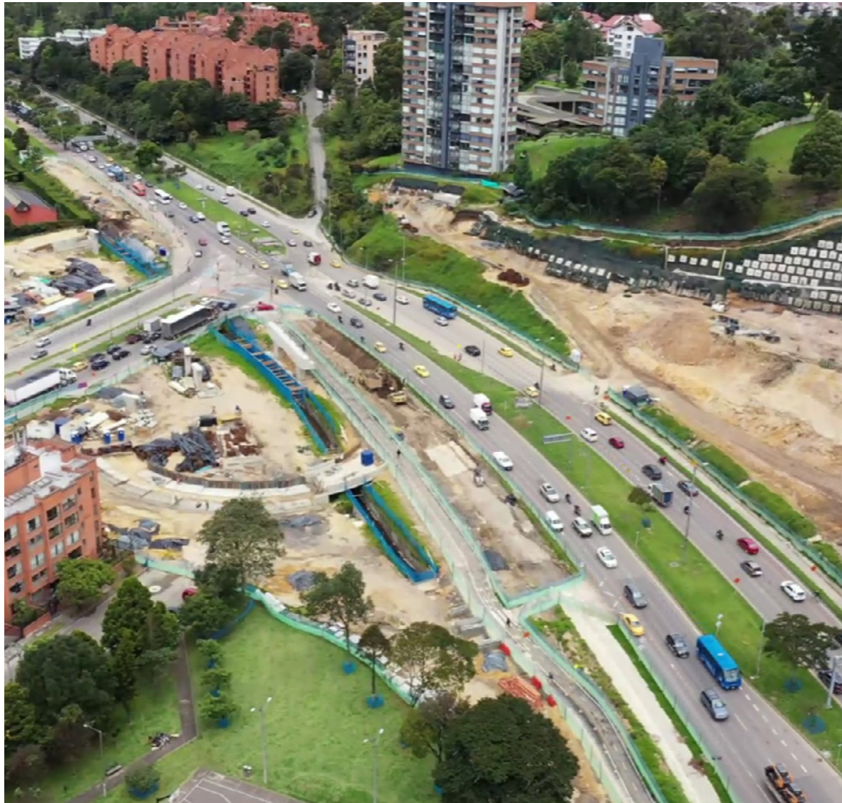
Construction of Avenida El Rincón. Colombia.
