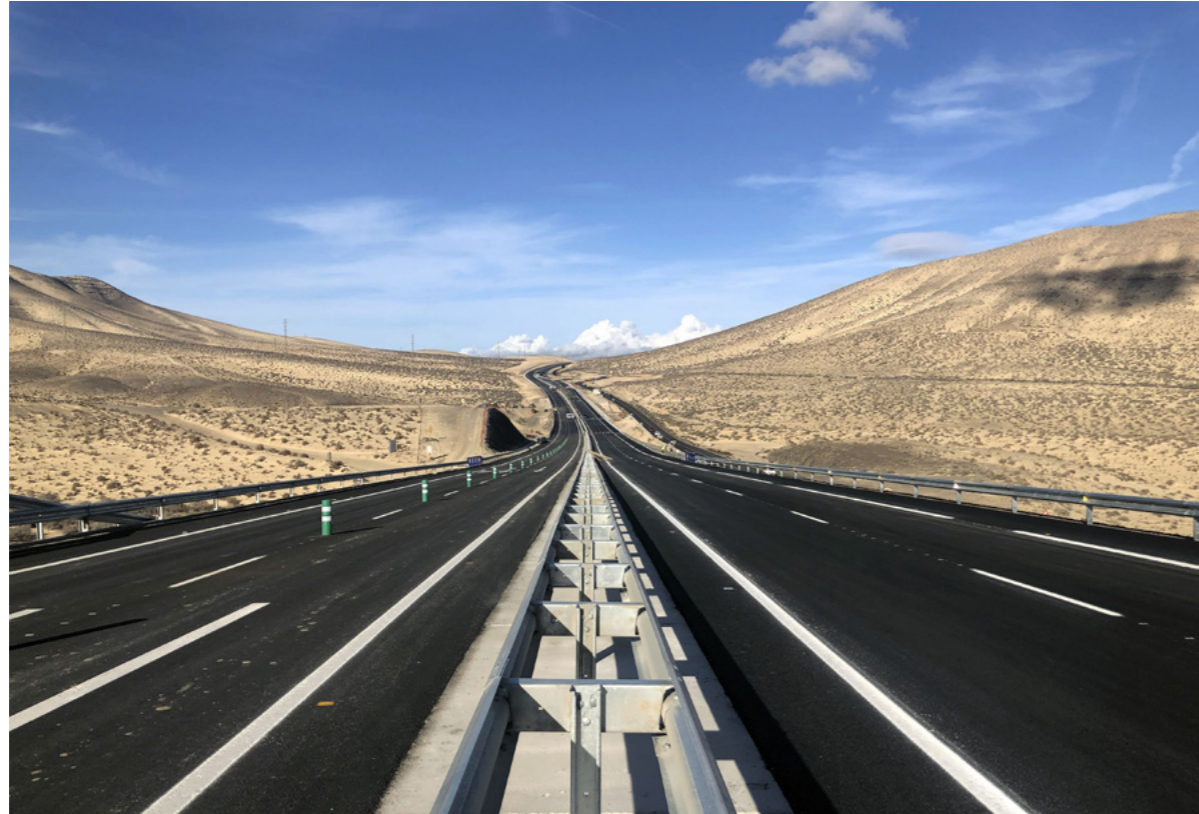
Aeropuerto-Tarajalejo Road. Fuerteventura. Spain.
