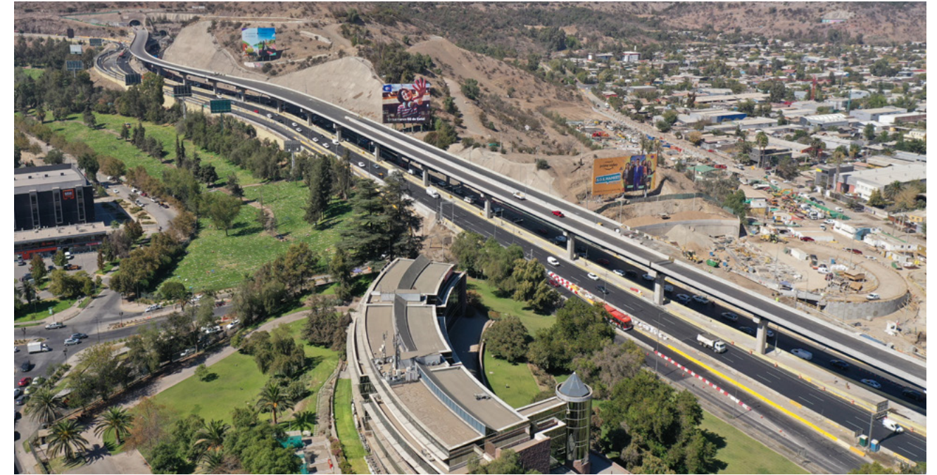
El Salto viaduct. Américo Vespucio Oriente I highway. Chile.
