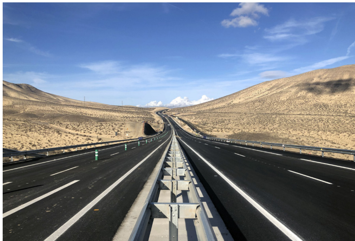
Aeropuerto-Tarajalejo Road. Fuerteventura. Spain.
