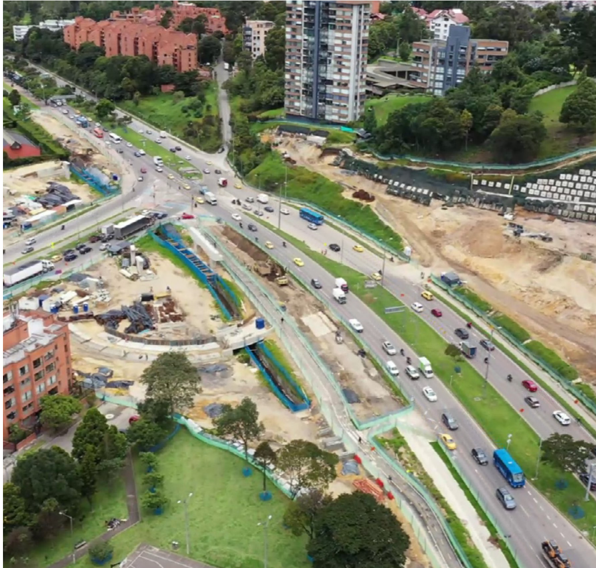
Construction of Avenida El Rincón. Colombia.
